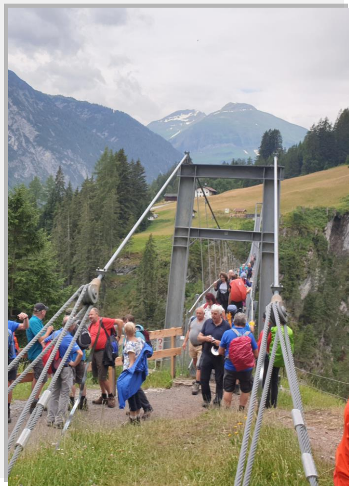
Abbildung 5 Die Holzgauer Hängebrücke
