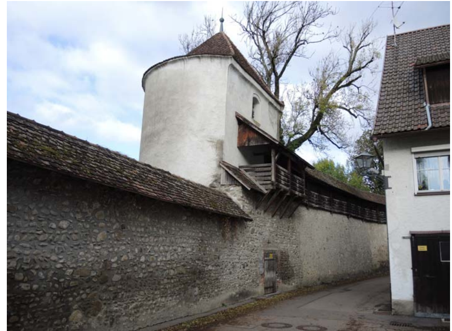
Ansicht des Speicherturm von Süden
