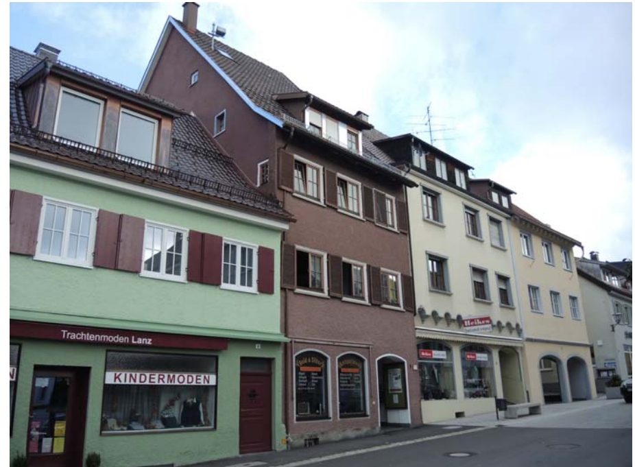
Ansicht des Gebäudes von Südwesten
