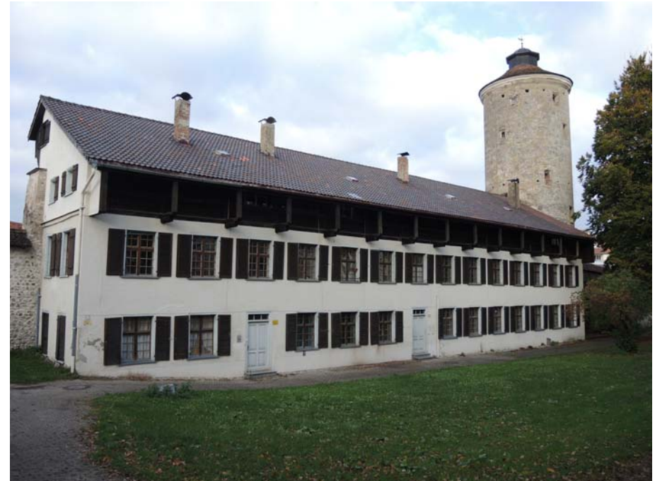
Ansicht des Gebäudes von Südwesten
