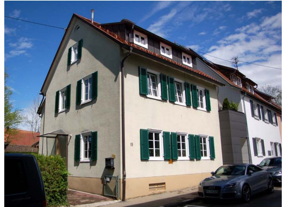
Ansicht des Gebäudes von Südwesten
