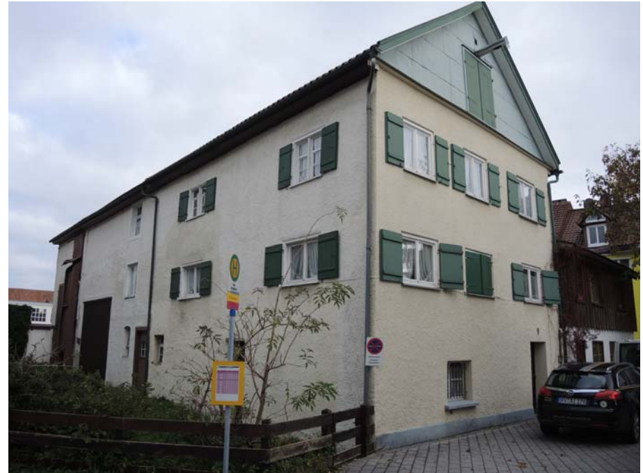
Ansicht des Gebäudes von Nordwesten
