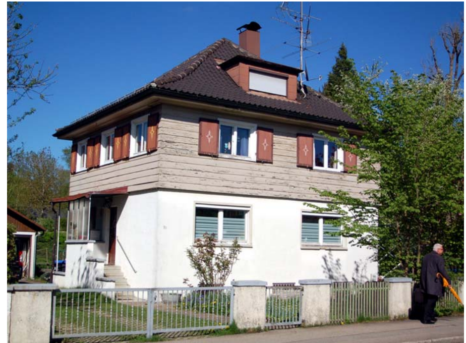
Ansicht des Gebäudes von Südwesten
