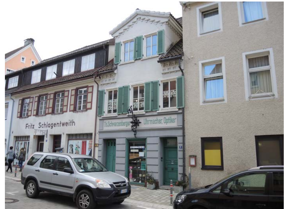
Ansicht des Gebäudes von Norden
