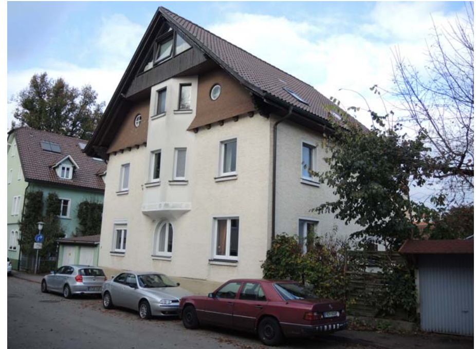
Ansicht des Gebäudes von Südwesten
