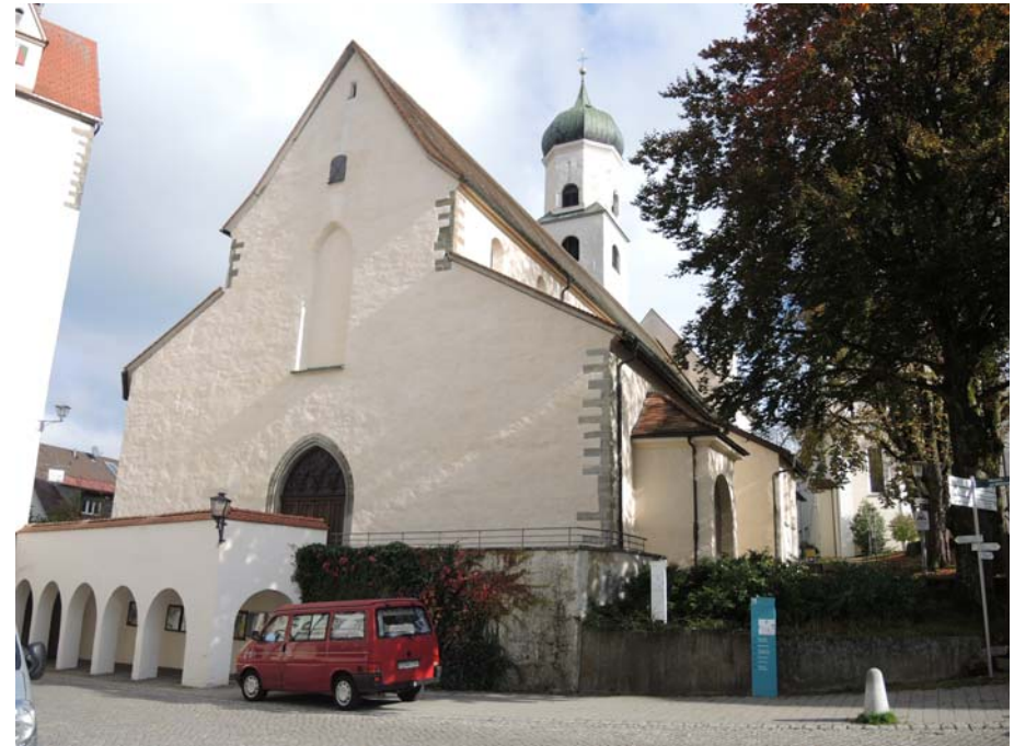
Ansicht der Kirche von Südwesten
