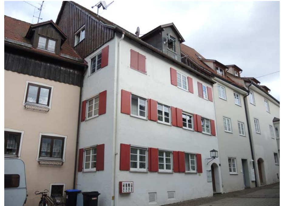
Ansicht des Gebäudes von Südwesten
