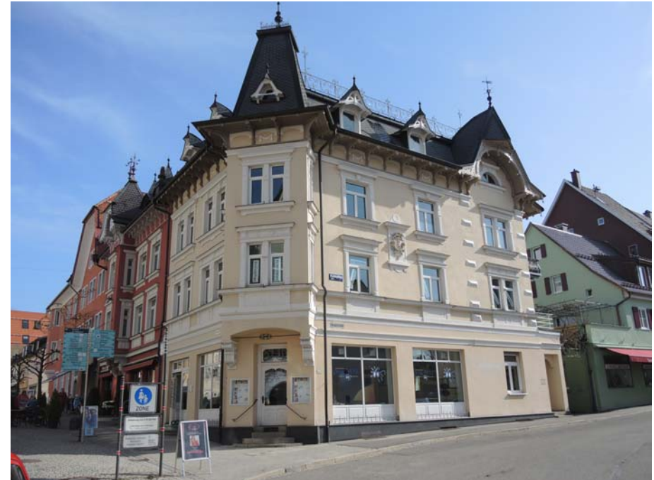
Ansicht des Gebäudes von Südwesten
