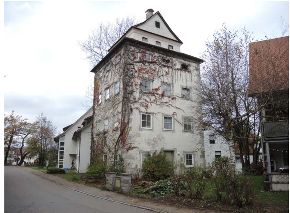
Ansicht des Wasserhauses von Süden
