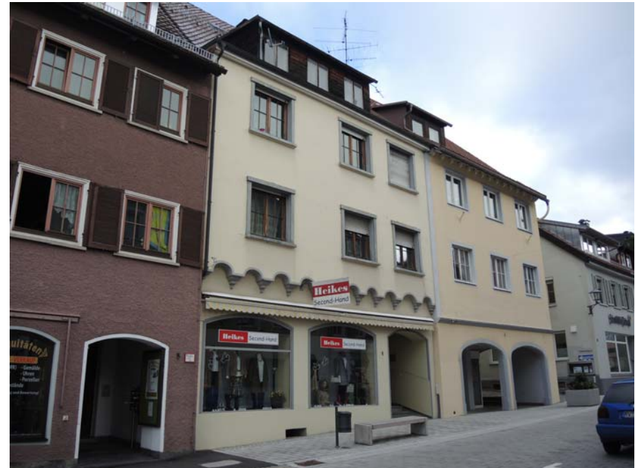
Ansicht des Gebäudes von Südwesten
