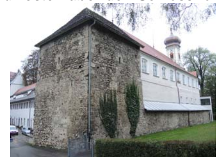
Blick auf den Pulverturm von Südosten
