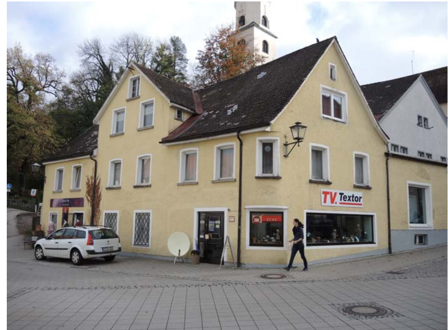
Ansicht des Gebäudes von Nordwesten
