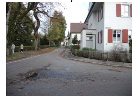
❷ Blick nach Nordosten bei Hausnr. 27
