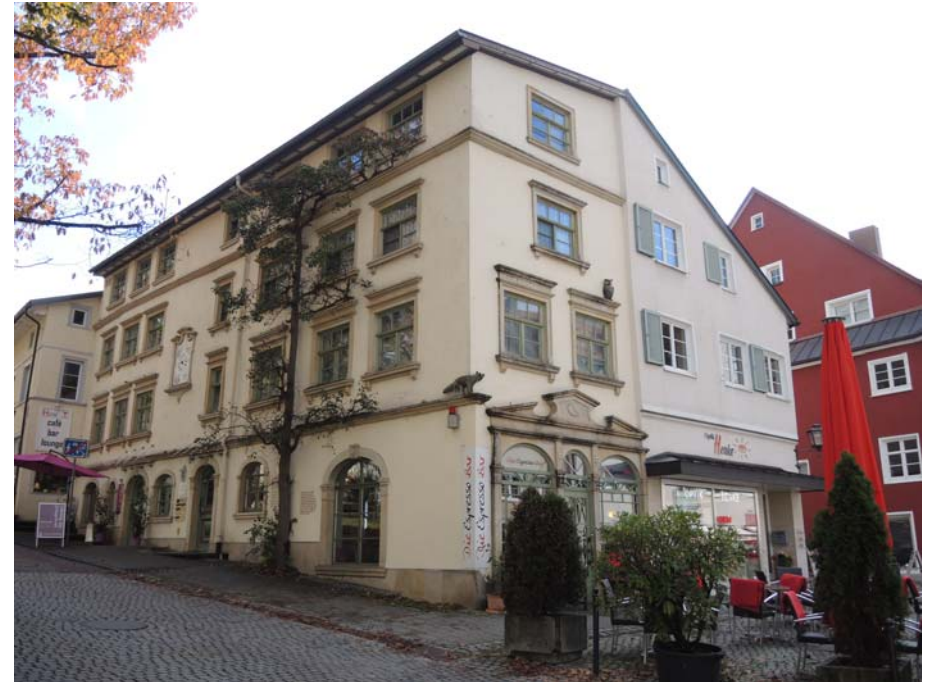
Ansicht des Gebäudes von Norden
