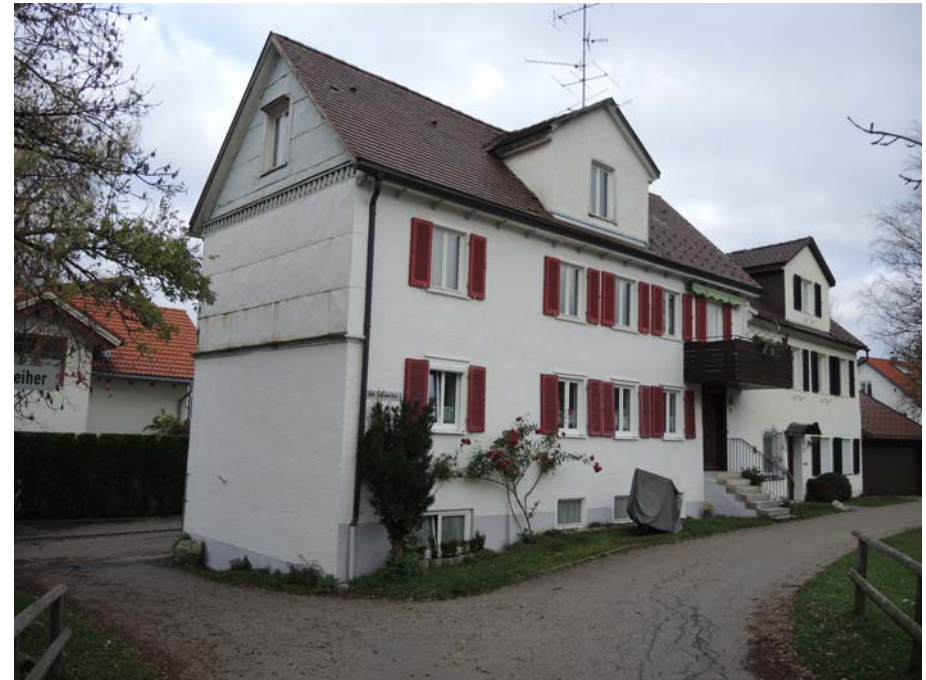
Ansicht des Gebäudes von Südwesten
