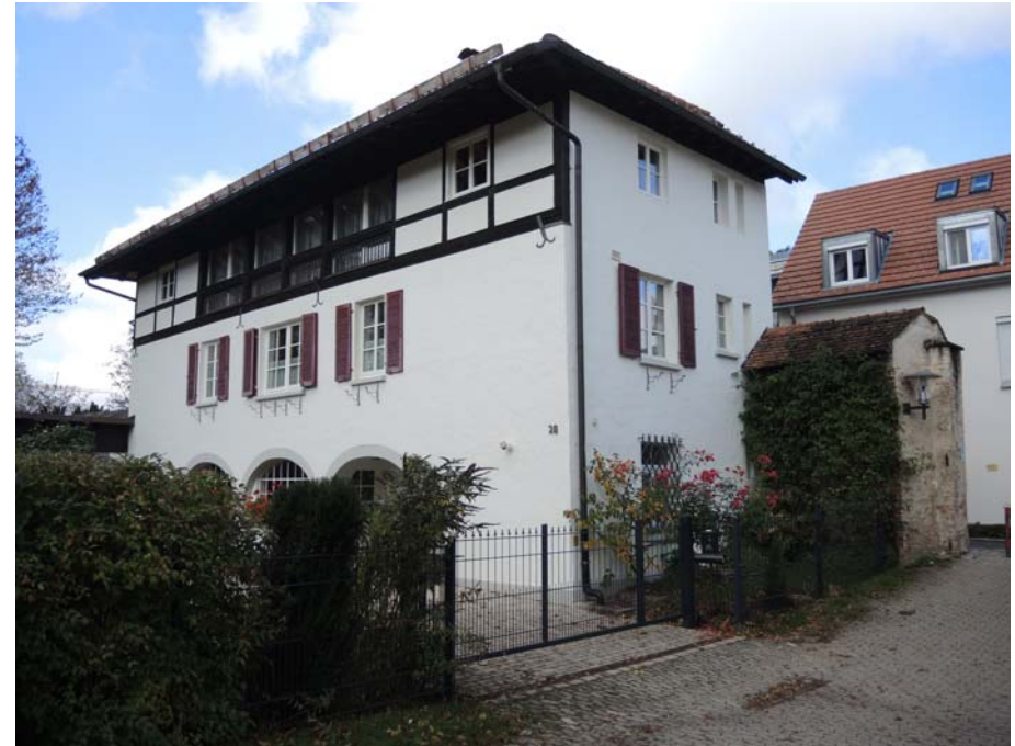
Ansicht des Gebäudes von Südosten
