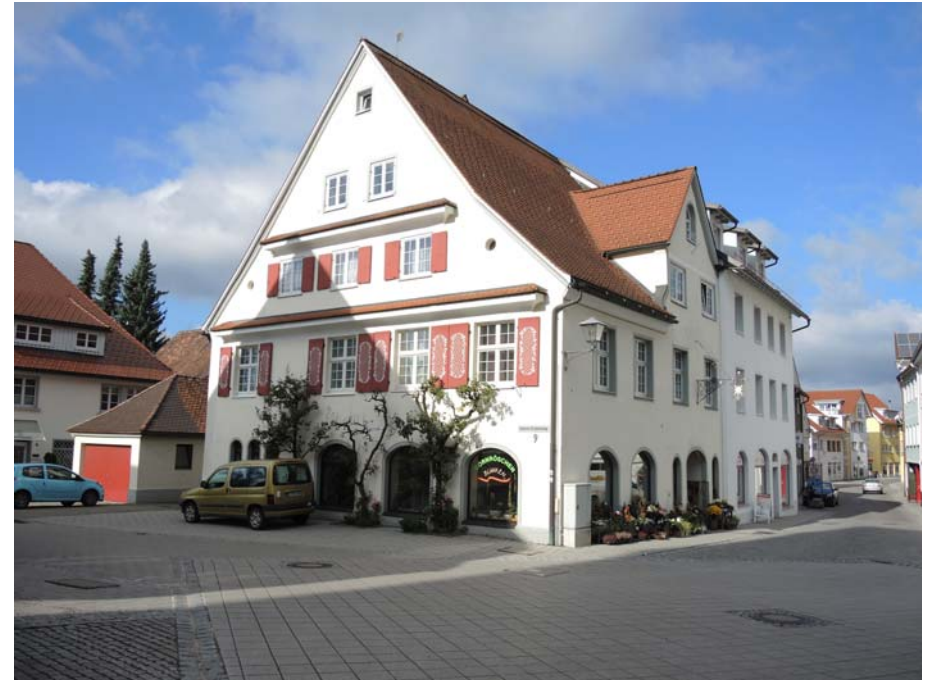
Ansicht des Gebäudes von Südosten
