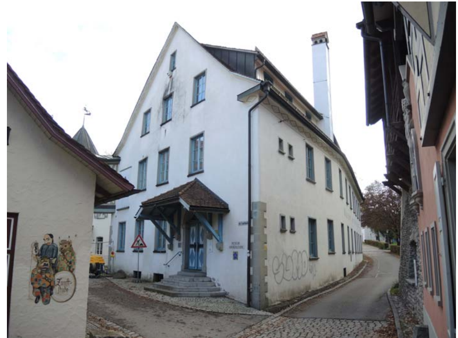
Ansicht des Gebäudes von Norden
