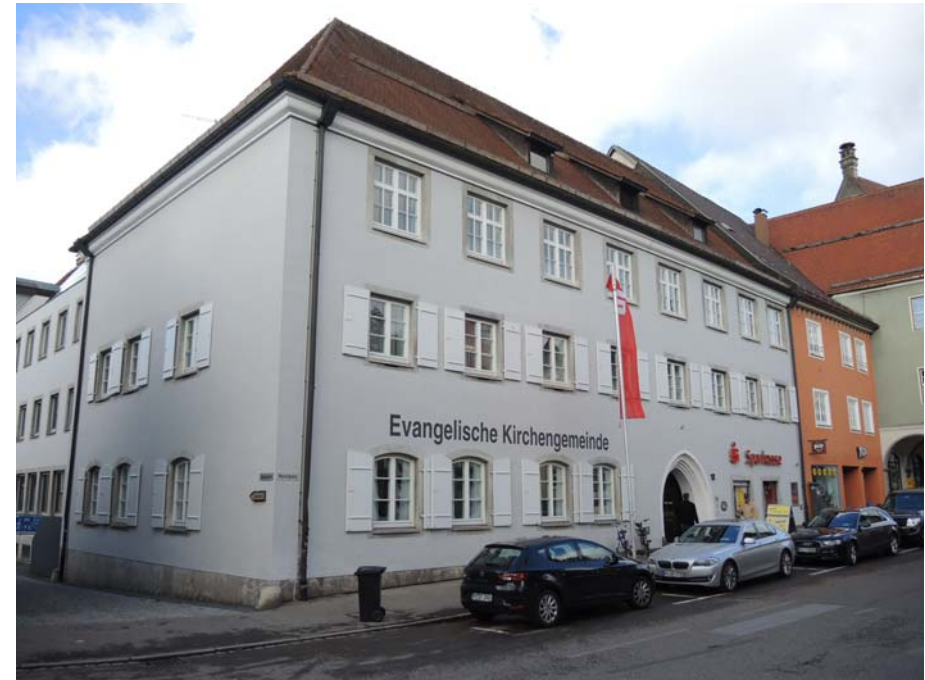
Ansicht des ehemaligen Spitals von Süden
