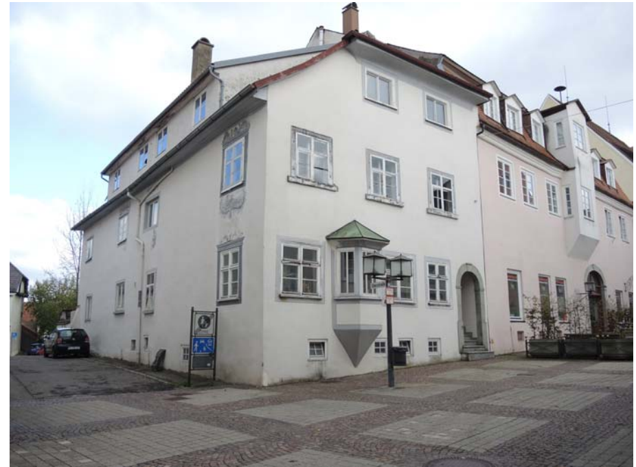
Ansicht des Gebäudes von Südwesten
