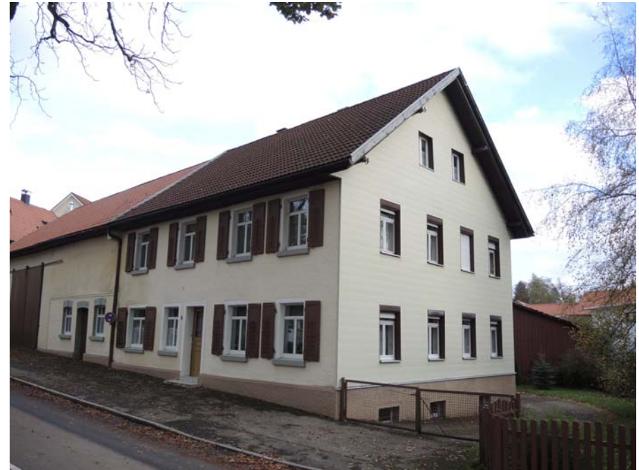
Ansicht des Gebäudes von Nordwesten
