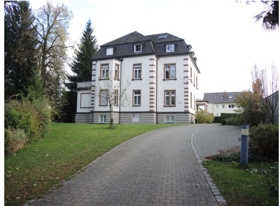
Ansicht des Gebäudes von Nordwesten
