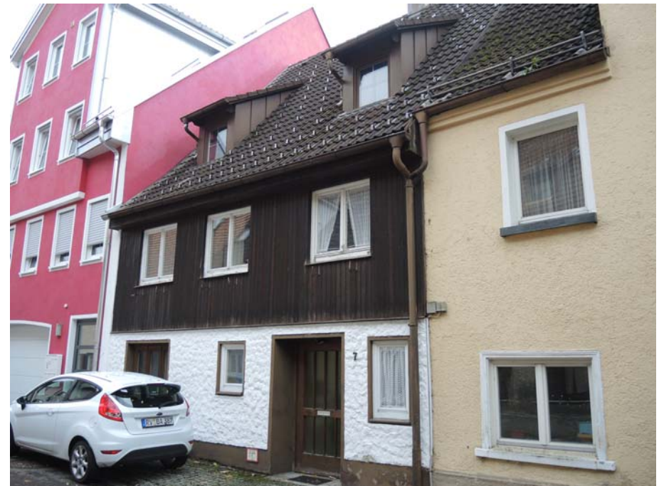
Ansicht des Gebäudes von Norden
