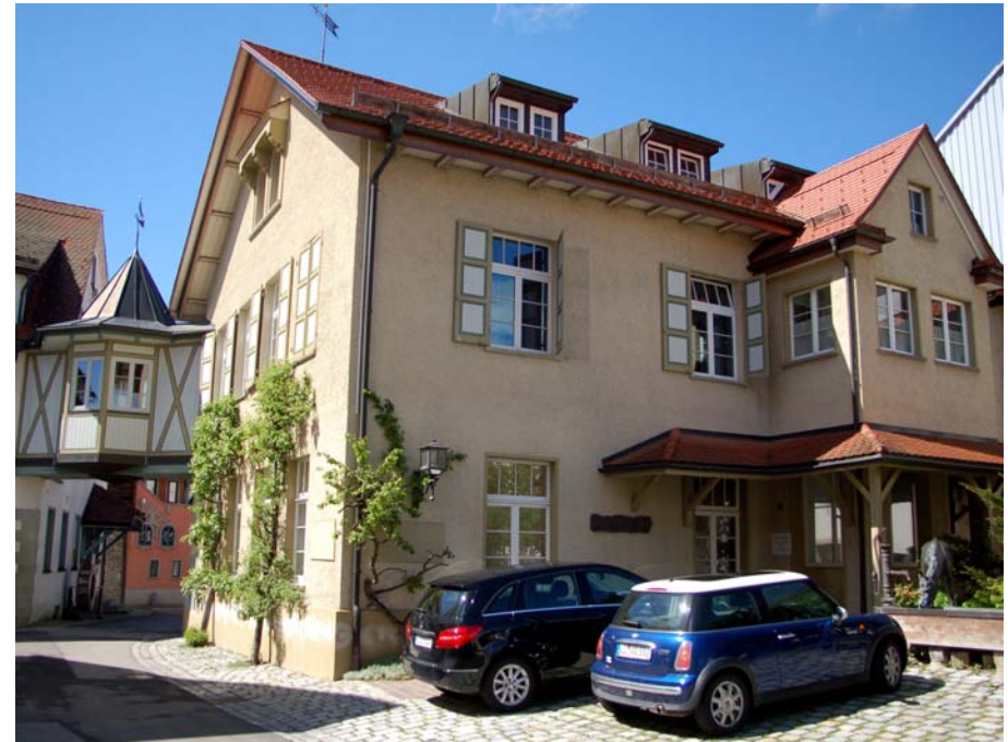
Ansicht des Gebäudes von Südosten
