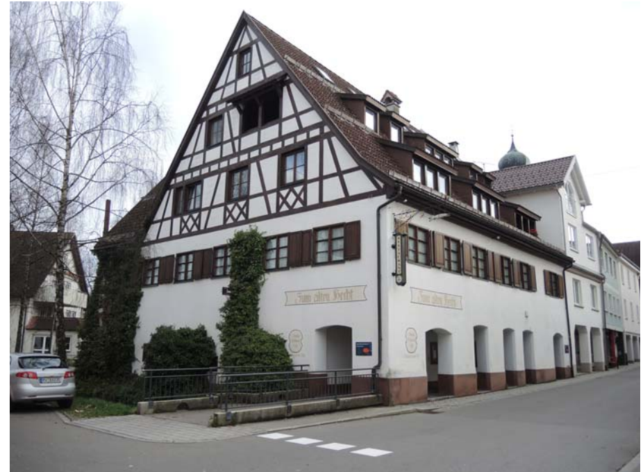
Ansicht des Gebäudes von Nordwesten
