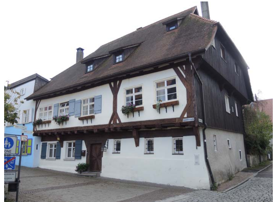
Ansicht des ehemaligen Pfarrhauses von Norden
