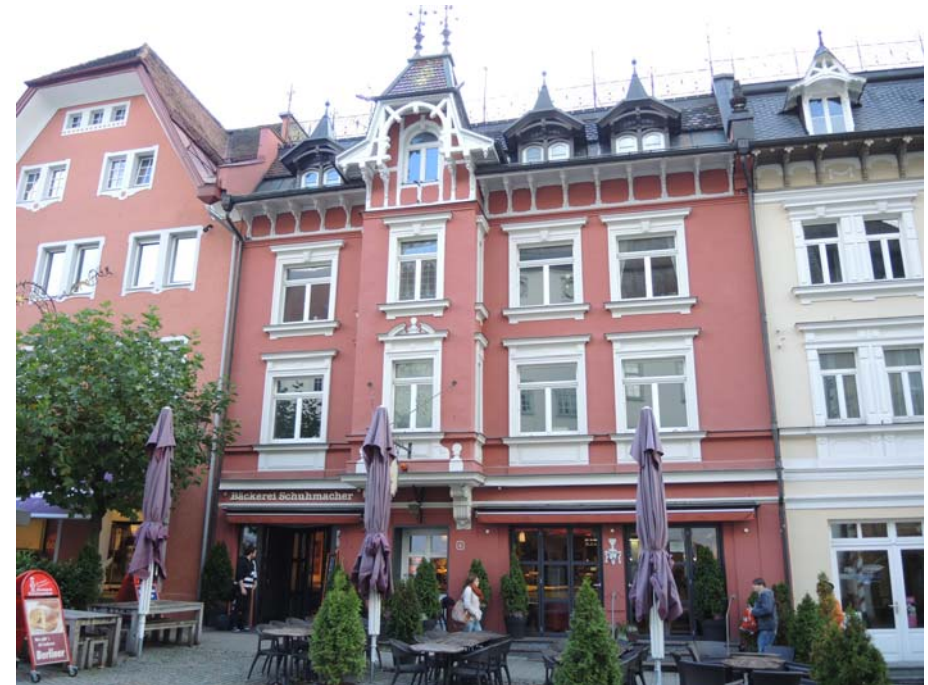
Ansicht des Gebäudes von Nordwesten
