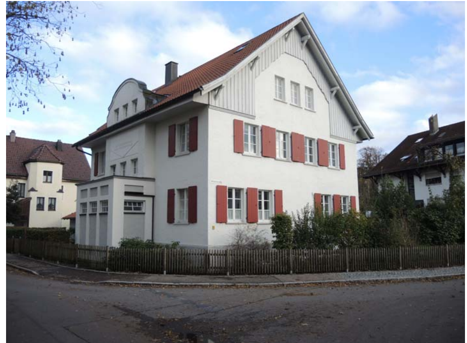
Ansicht des Gebäudes von Nordwesten
