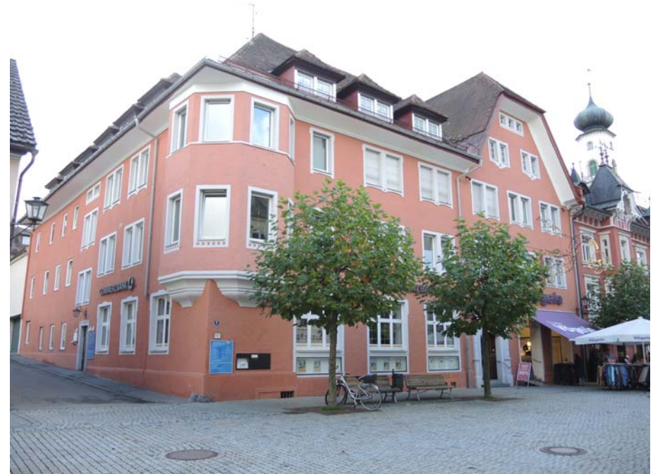
Ansicht des Gasthauses von Norden
