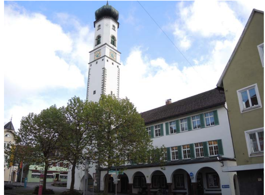
Ansicht des Blaserturms von Südwesten
