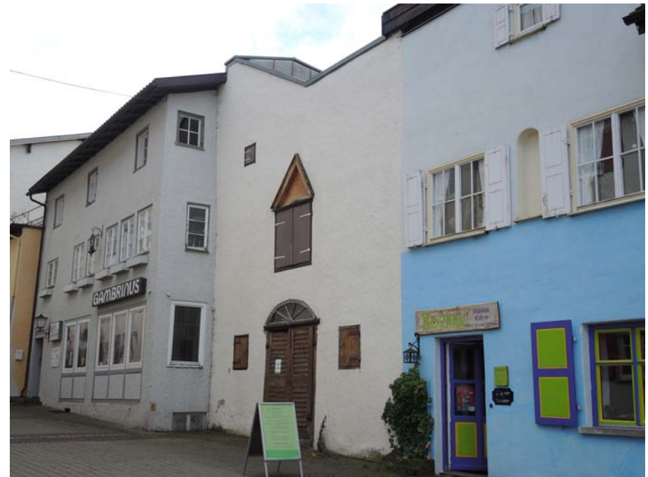
Ansicht des Gebäudes von Nordwesten
