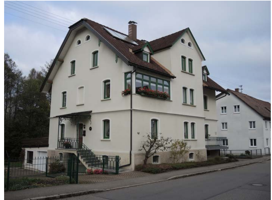
Ansicht des Gebäudes von Südwesten
