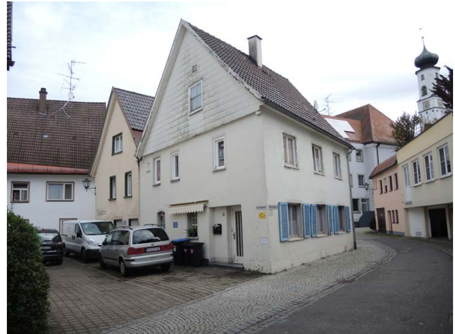
Ansicht des Gebäudes von Südwesten
