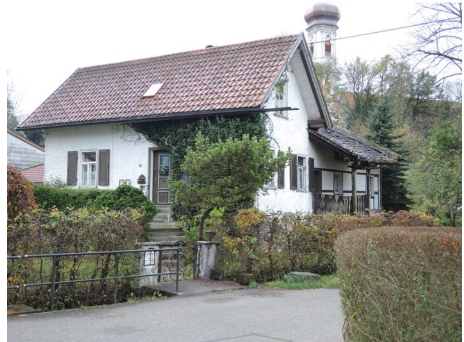
Ansicht des Gebäudes von Norden
