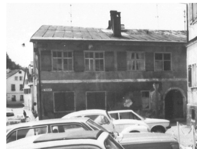
Ansicht von Norden 1978
