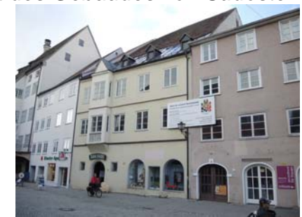
Ansicht von Nordosten
