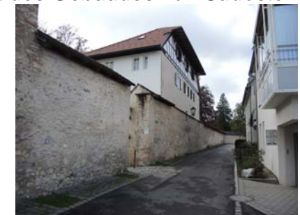
Ansicht von Nordosten
