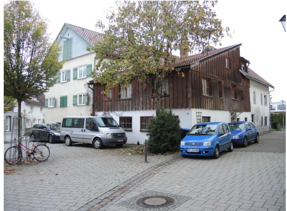
Ansicht des Gebäudes von Südwesten
