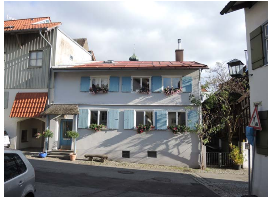
Ansicht des Gebäudes von Nordwesten
