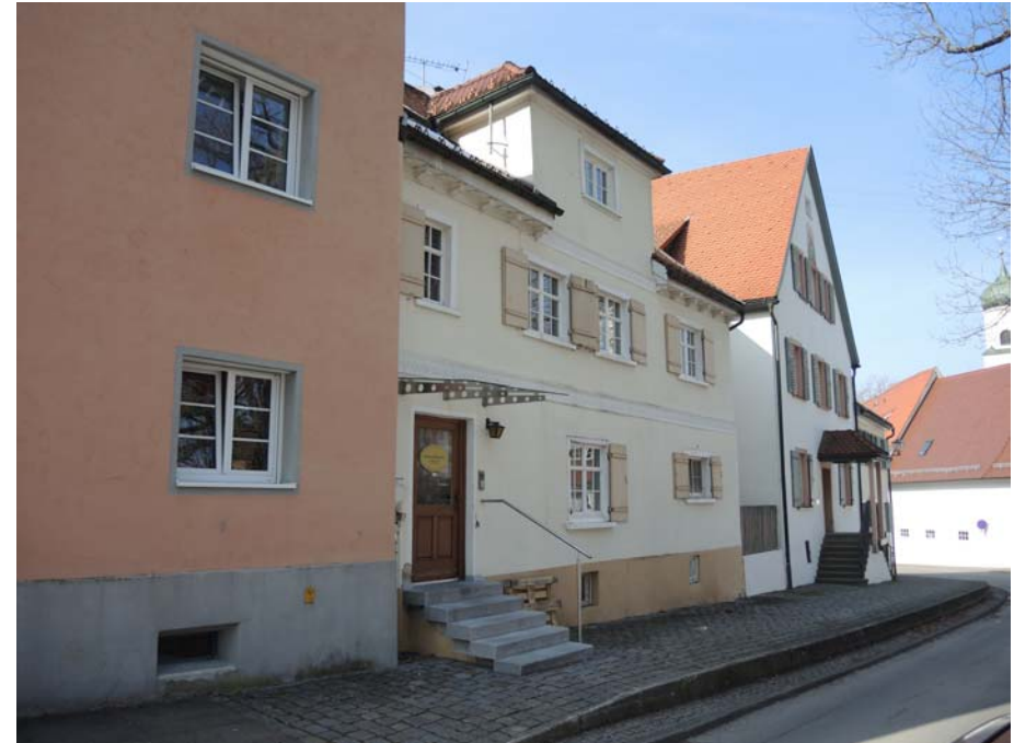
Ansicht des Gebäudes von Südosten
