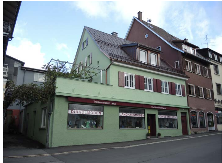
Ansicht des Gebäudes von Südwesten
