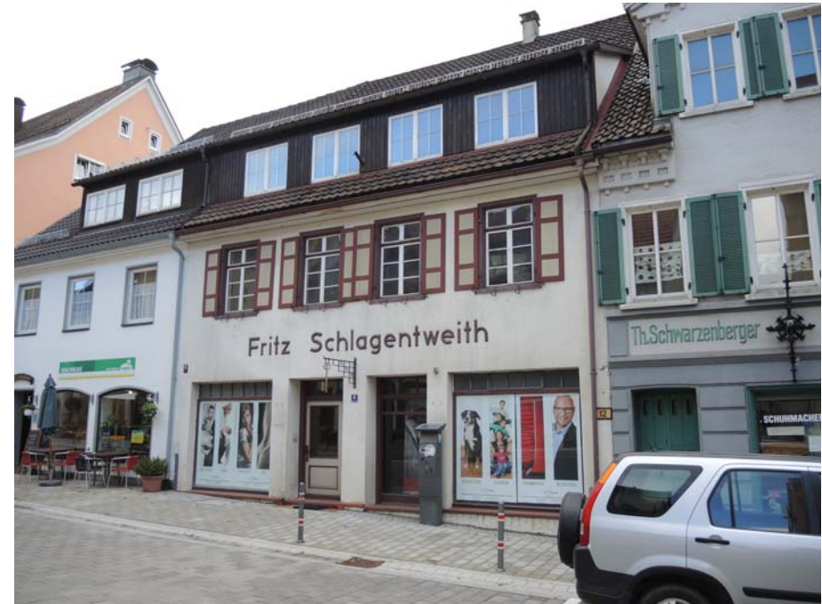
Ansicht des Gebäudes von Norden
