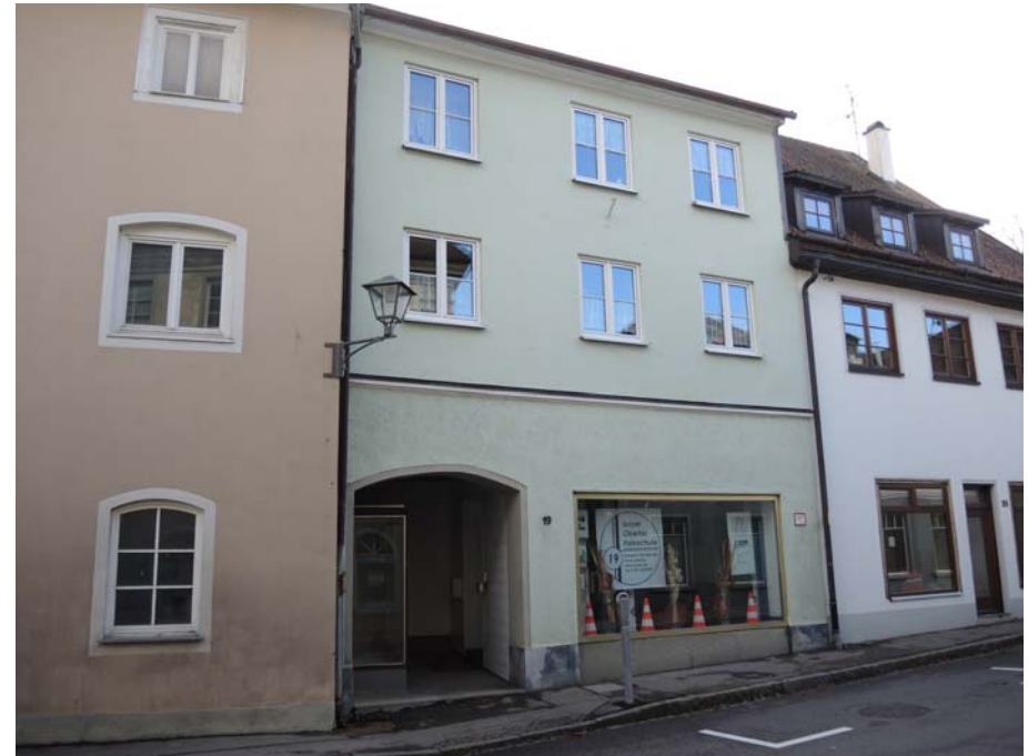
Ansicht des Gebäudes von Norden
