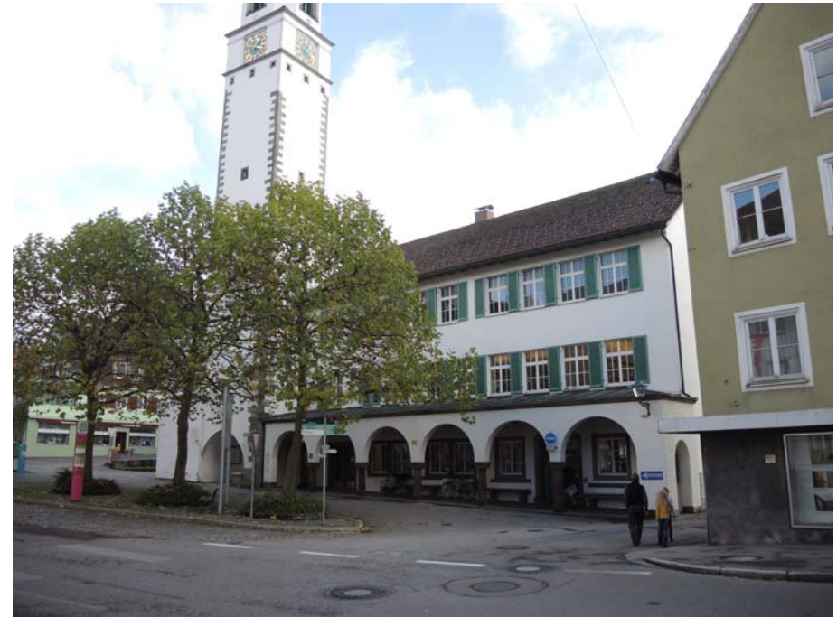
Ansicht des Blaserturms von Südwesten
