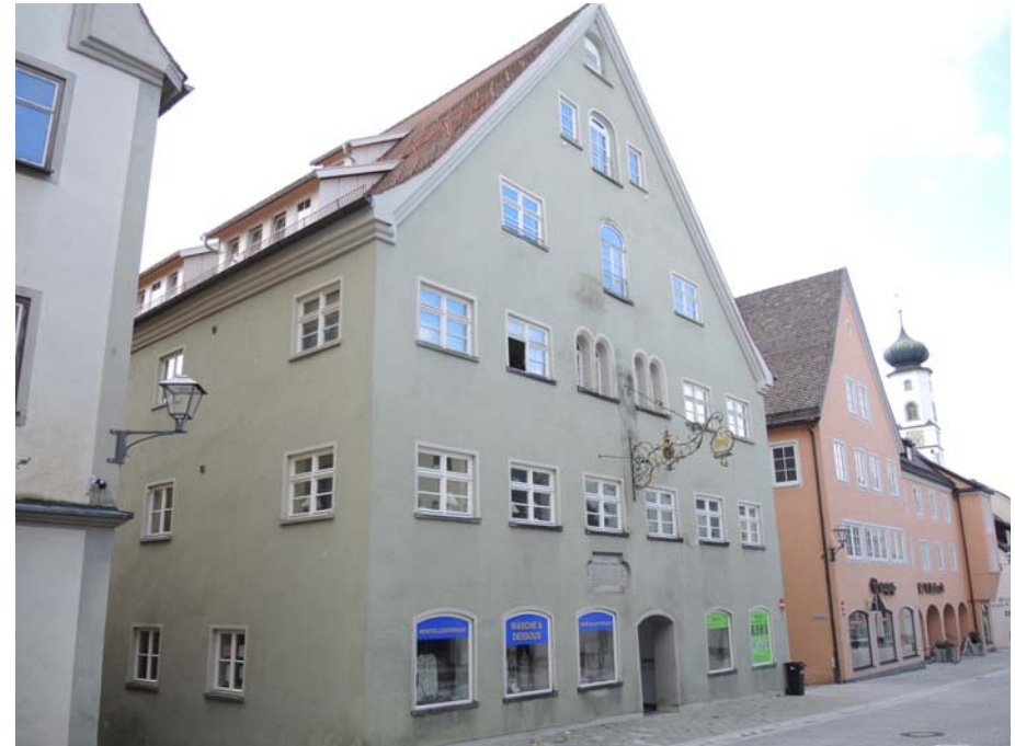
Ansicht des Gasthauses von Osten
