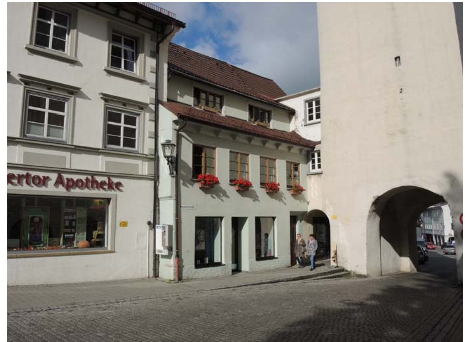
Ansicht des Gebäudes von Südosten
