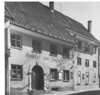
Ansicht von Norden 1962
