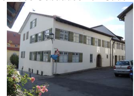
Ansicht von Nordosten
