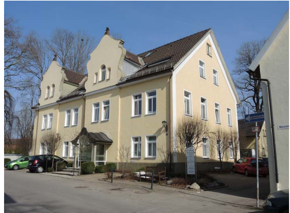
Ansicht des Gebäudes von Südwesten
