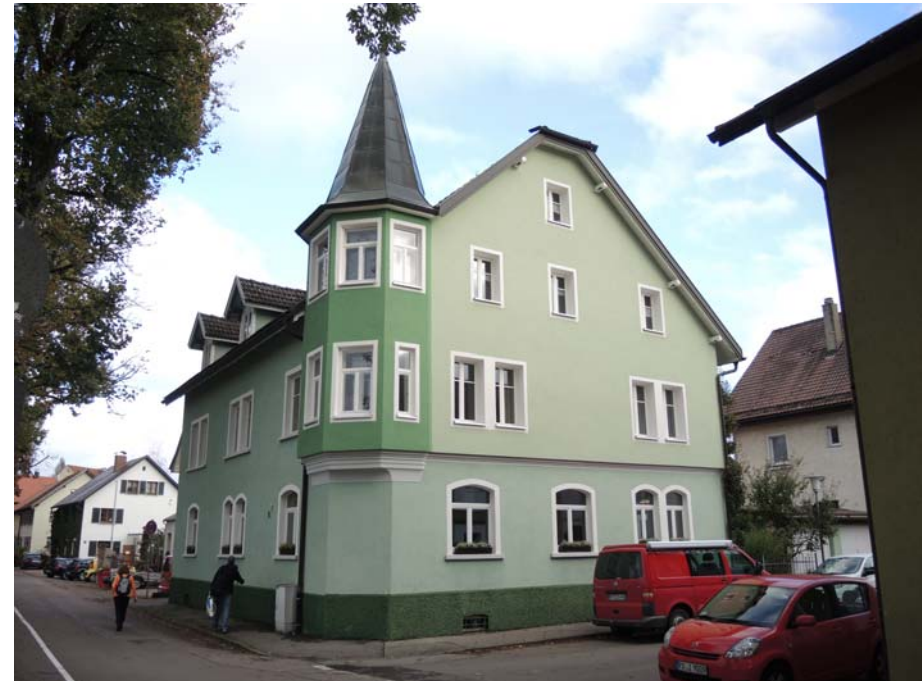
Ansicht des Gebäudes von Nordwesten
