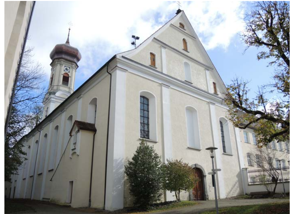
Ansicht der Kirche von Nordwesten
