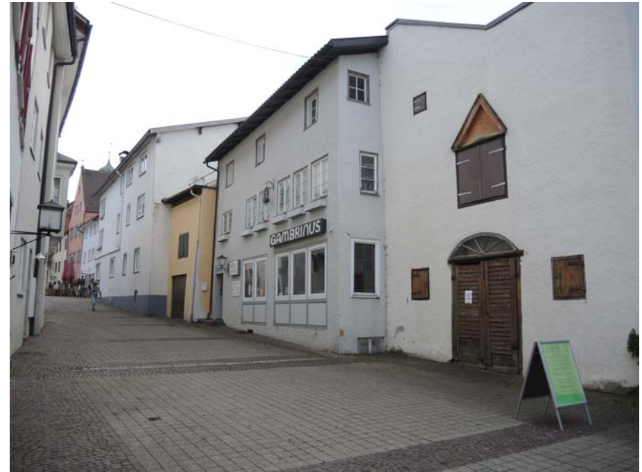
Ansicht des Gebäudes von Nordwesten
