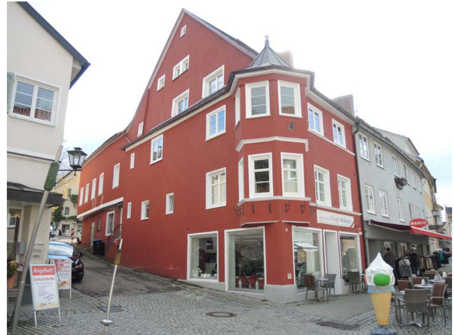
Ansicht des Gebäudes von Norden
