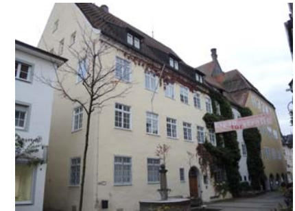
Ansicht Espantorstraße 6 von Westen
