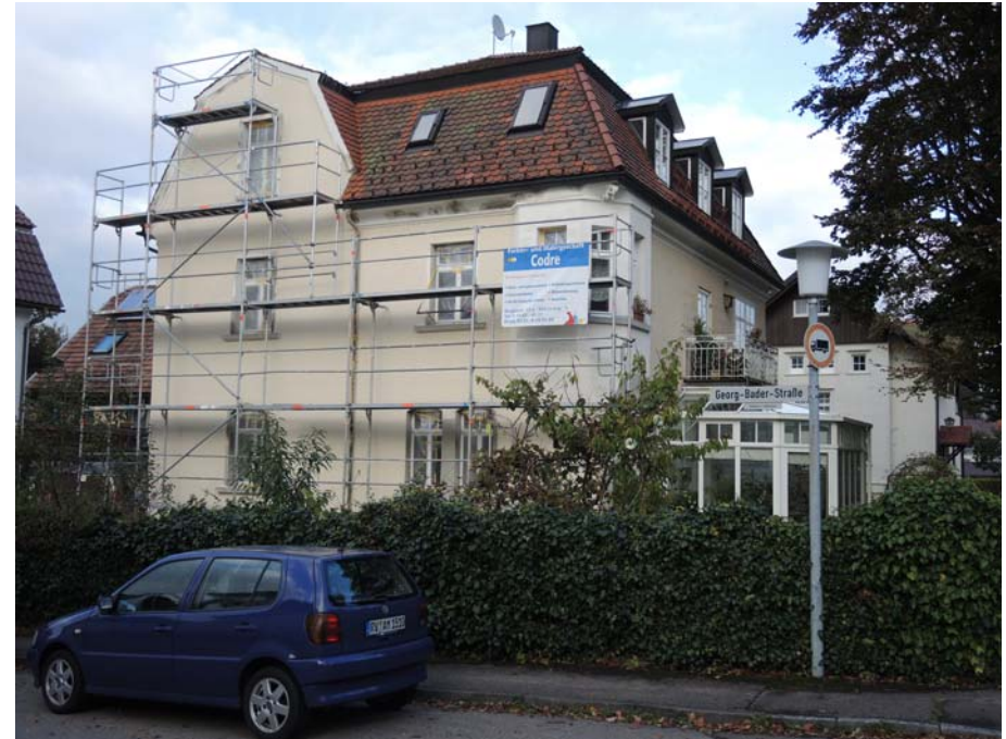
Ansicht des Gebäudes von Südwesten
