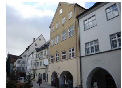
Ansicht von Nordosten
