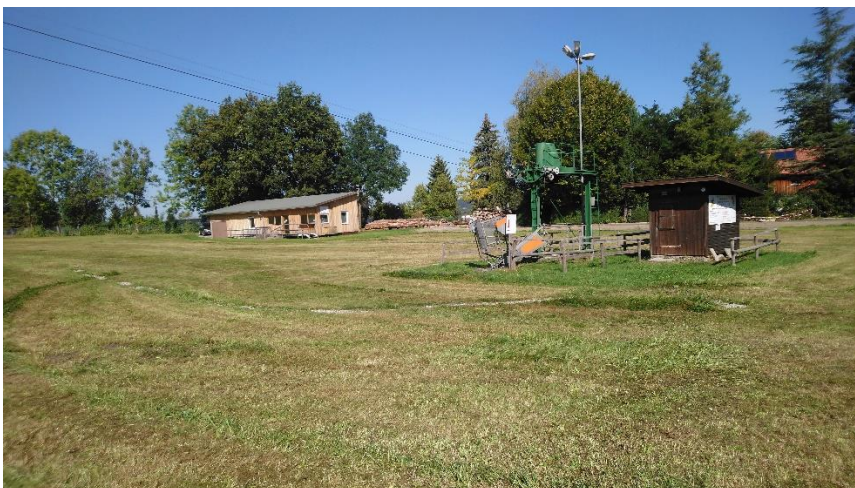
Abbildung 6: vorhandene bauliche Anlagen
